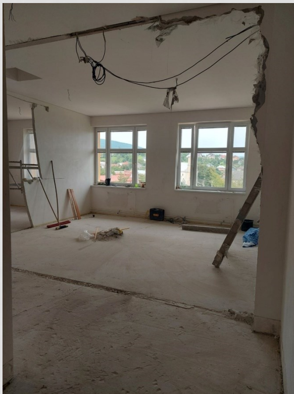
Počas realizácie stavebných úprav
