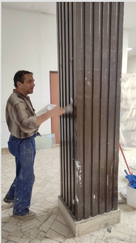
Oprava poškodených plôch
